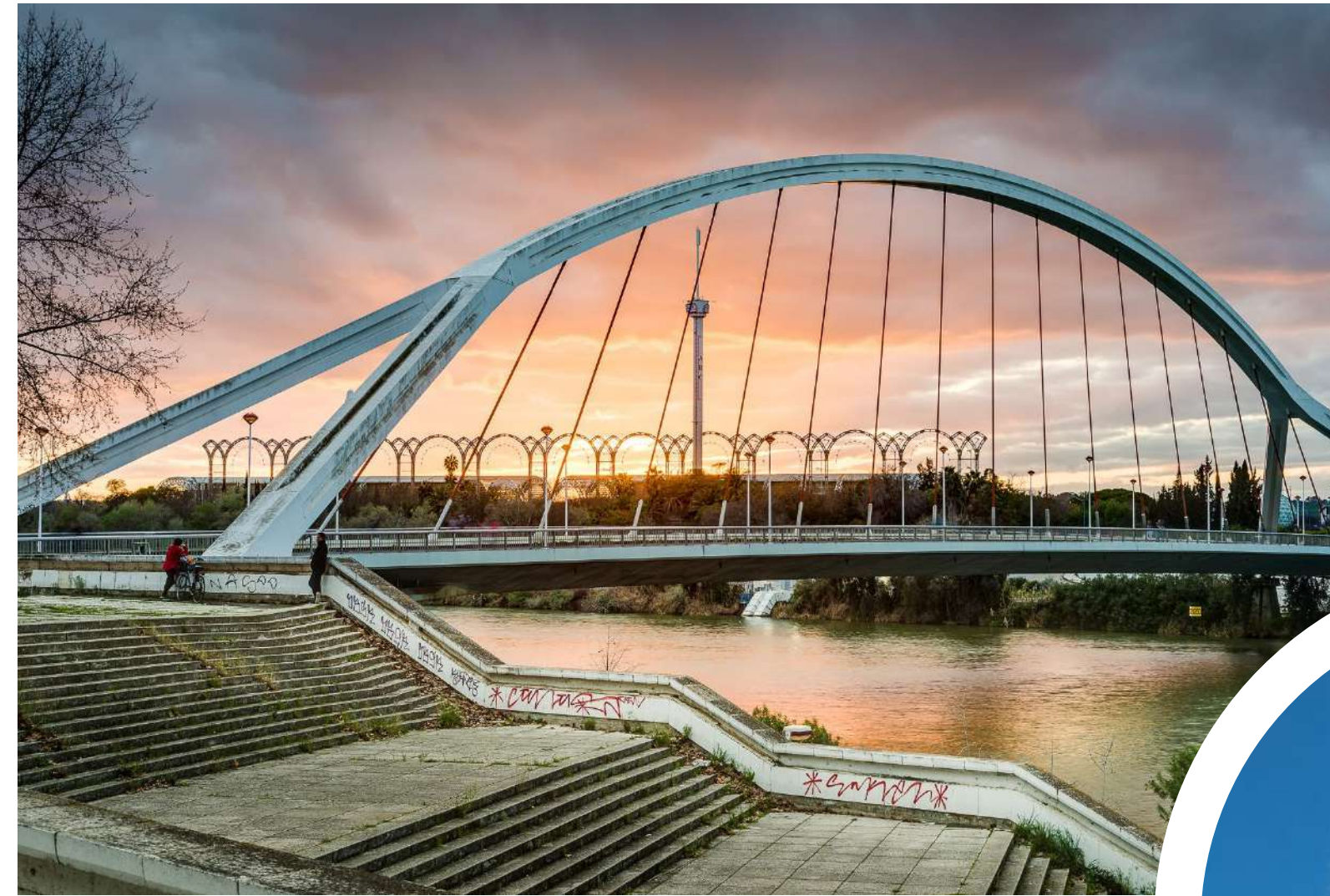
Puente de La Barqueta
